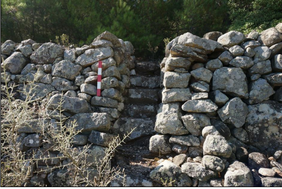
Resim 4: Güvercinlik Mevkii teras duvarlarından görünüm
