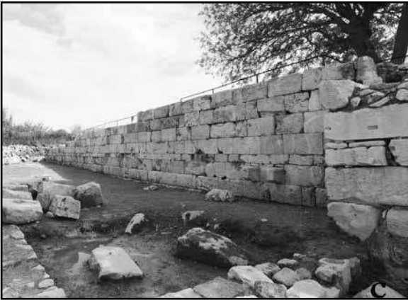
Resim 8c: Restorasyon sonrası, Bouleuterion Batı (Arka) duvarı.
